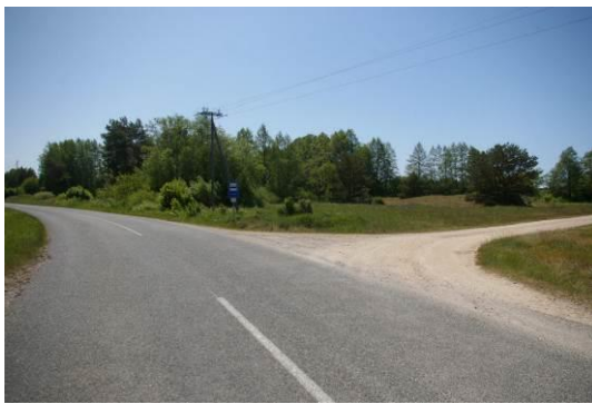
Kopskats no autoceļa V1231 puses
